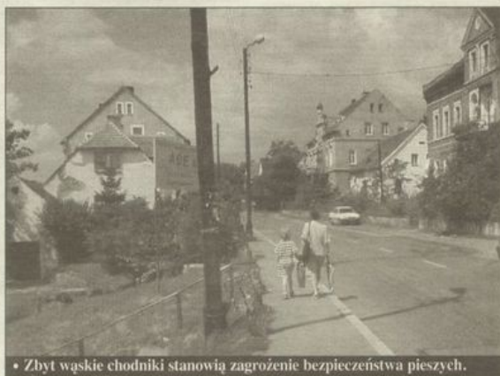
• Zbyt wąskie chodniki stanowią zagrożenie bezpieczeństwa pieszych.
