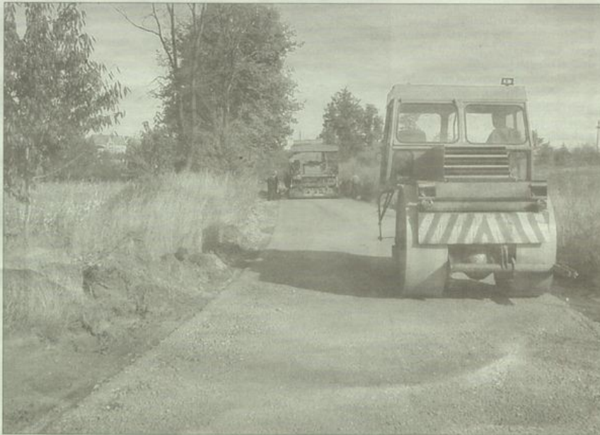
Na ulicy Łowieckiej rozpoczęły się już prace remontowe.
