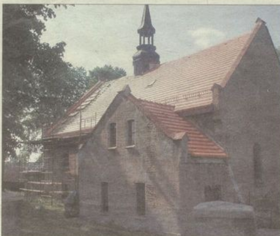
Dach kościoła w Stoszowie już jest w remoncie.
