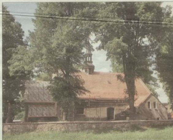
Kościół w Stoszowie tuż przed zakończeniem remontu.
