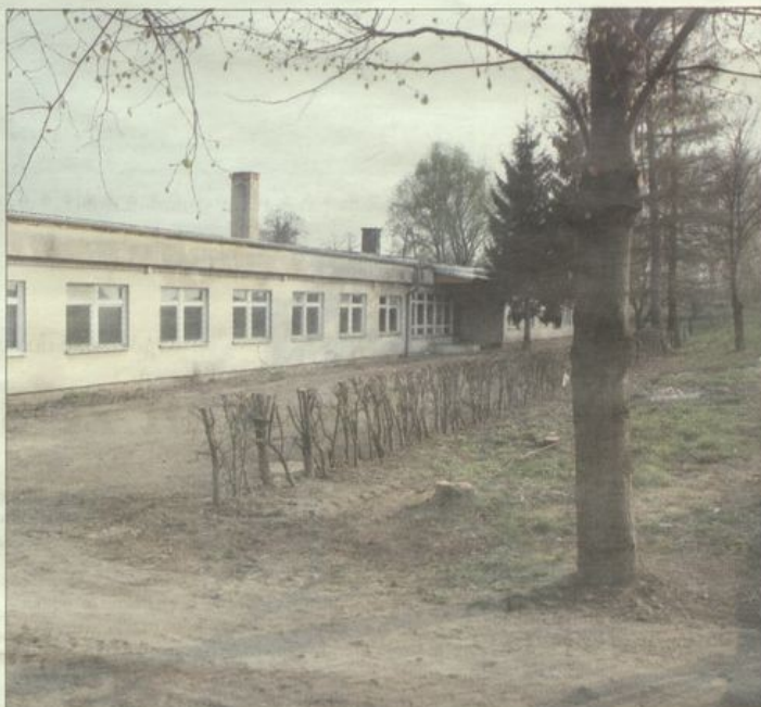
Przy hotelu uporządkowano teren, wykonano nowe pokrycie dachu. Prace są kontynuowane.
