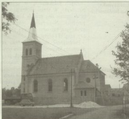
Kościół w Sieniawce w trakcie remontu.
