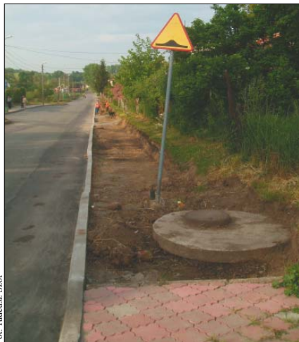
Tak było przed remontem....
